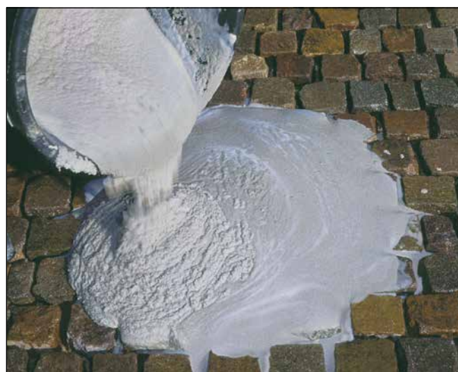
4 Joint époxy Sopro EPF bicomposant prêt à la mise en œuvre.
