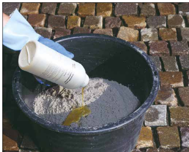
2 Ajout du durcisseur et préparation du Joint époxy Sopro EPF.
