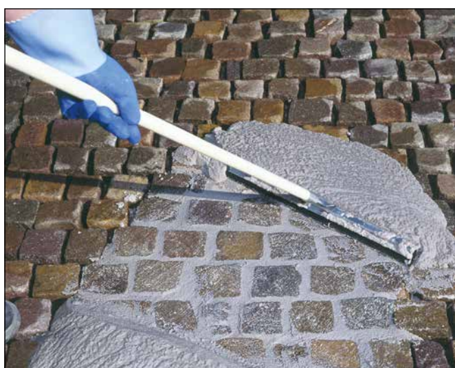
5 Application du Joint époxy Sopro EPF.
