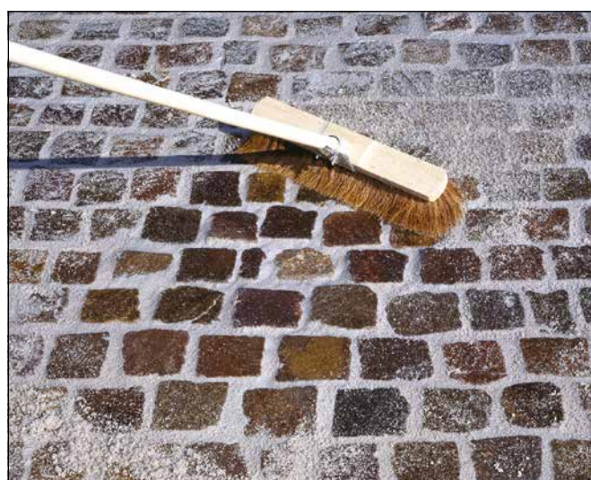
6 Nettoyage du revêtement.
